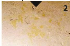
Opravené defekty – štuk, tmel (+Primalex Hĺbková PENETRÁCIA)
