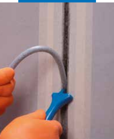
Vloženie polyetylénového povrazca Mapefoam za účelom vydimenzovania hĺbky škáry
