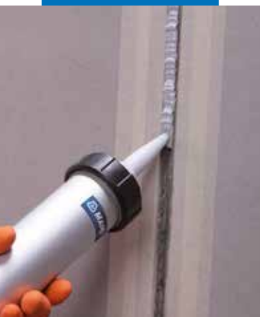
Aplikácia Mapeflex PU40
